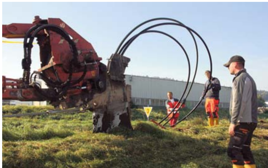
Beim Einpflügen halten zwei Männer der Firma Weigand die drei 50 Millimeter dicken Kunststoffrohre, damit sich die Rohre nicht verheddern. Rechts Kapo André Weigand.
