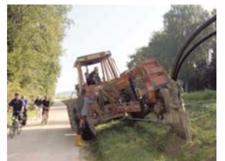
Den Damm vor dem Bahnübergang Steppach pflügt der Traktor in Hanglage.
